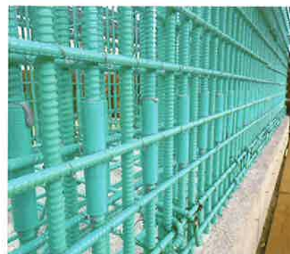
エポキシ樹脂塗装ねじ鉄筋継手の配筋
